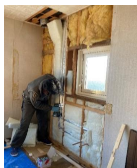
現場 作業 風景
