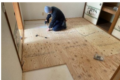
現場作業風景
